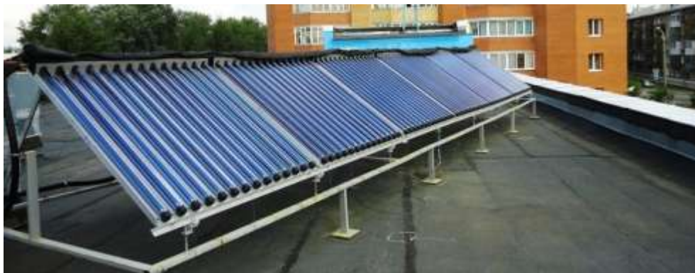
Вакуумный солнечный коллектор для обогрева бассейнов и душевых фитнес-клуба
